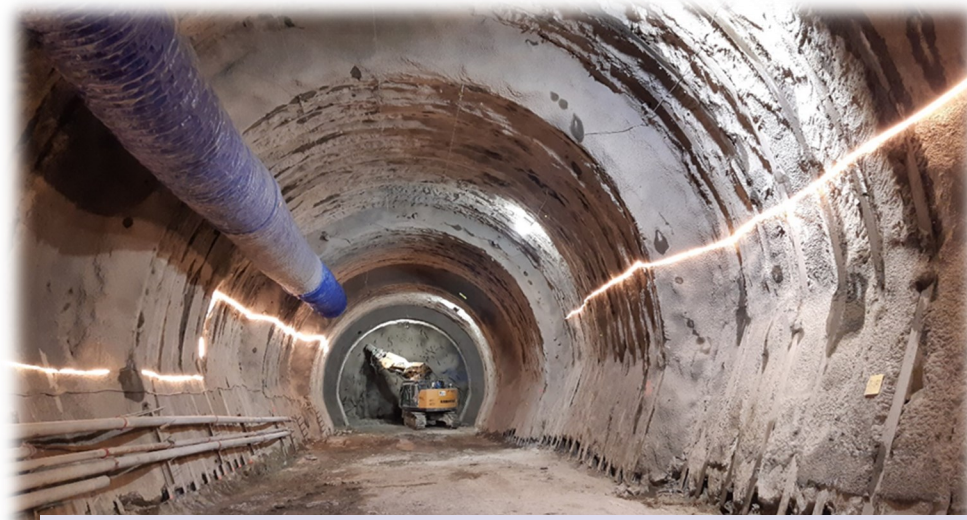
Zone C0.08 Tunnel confectionné avec la méthode traditionnelle
