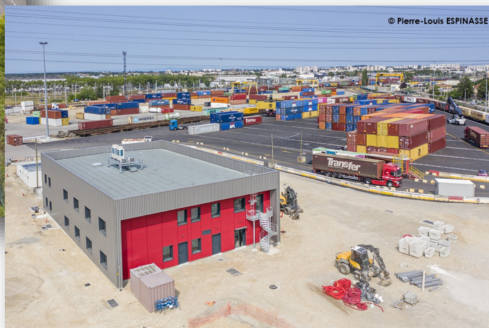
↳ Le nouveau bâtiment administratif
