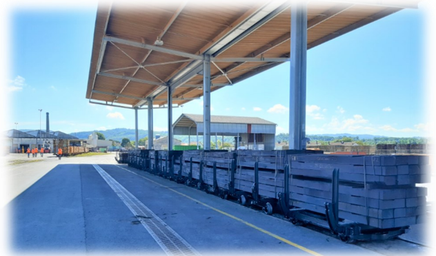
Traverses bois qui viennent de sortir des autoclaves de créosotage Crédit Photo : Tristan BACHELARD
