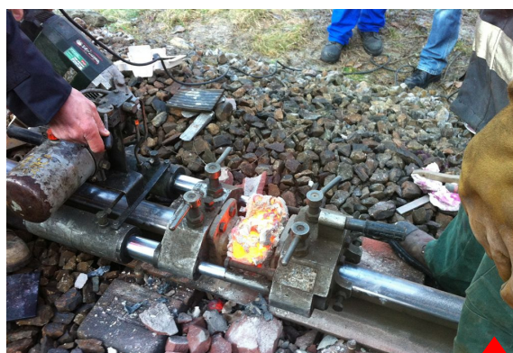
Photo 9 - Tranchage du surplus
