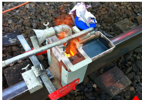
Photo 6 - Préchauffage du moule
