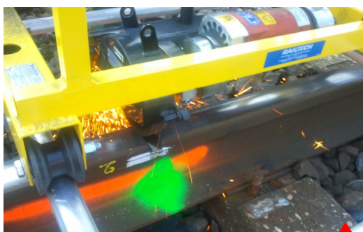
Photo 1 - Usinage du défaut
