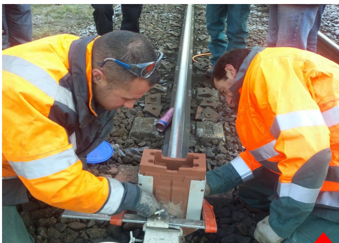
Photo 5 - Mise en œuvre du moule
