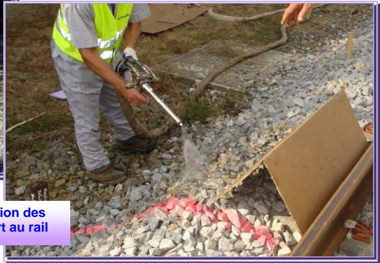
Application du produit Canasoil (avec protection des attaches), et au gabarit de distance par rapport au rail
