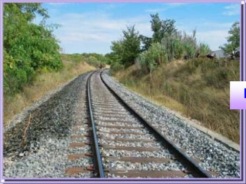
**Problématique :** une quantité insuffisante de ballast à l'extérieur des têtes de traverses risque de permettre à la voie de riper latéralement sous l'effet de la chaleur (déformation), ou des efforts dynamiques des véhicules sur la file haute (défaut de dressage).
