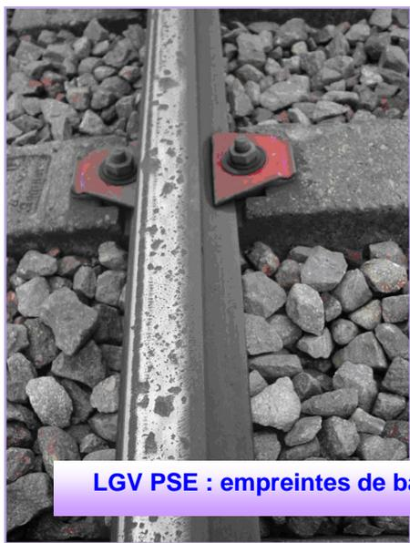
Des trains, des installations et des aménagements proches de la voie peuvent être endommagés. Le problème est particulièrement aigu en hiver, lorsque des morceaux de glace se détachent des trains et tombent sur le ballast, provoquant ainsi des projections de ballast.
