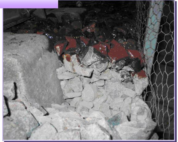
La quantité de colle utilisée va de 0,4 à 1kg/m<sup>2</sup> (selon la courbe granulométrique, la pureté du ballast et la température). Lorsque la production de colle sortie / volume est de 20 l/minute, la quantité de colle, 0,5 kg/m<sup>2</sup>, et la surface, 2,5 m<sup>2</sup> au mètre courant, on peut appliquer du produit sur une longueur d'environ 960 mètres par heure.
