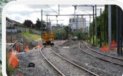
Ripage de la Voie 2 GC
